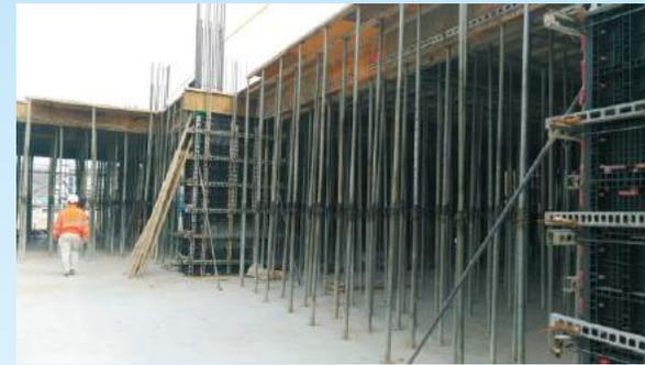
●半系統施工即樑、版結構採用夾板，可降低師傅進入障礙。(泰亞營造工地)
