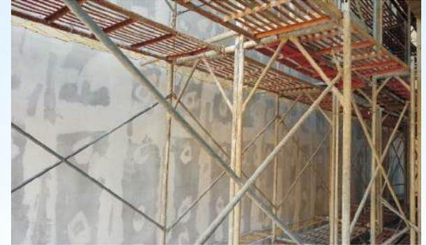
●結構完成面平整，可以直接上黑土免除1：3沙漿費用。(聚德建設工地)
