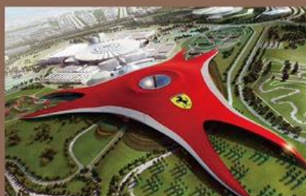
工程實績：法拉利遊樂館
